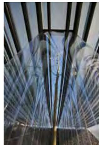
O novo pavilhão inferior ao nível da quota natural do terreno. As grandes paredes sustentam a estrutura de tubos circulares, dispostos paralelamente. A cobertura transparente de ETFE é formada por uma camada dupla pré-tensionada que proporciona um
