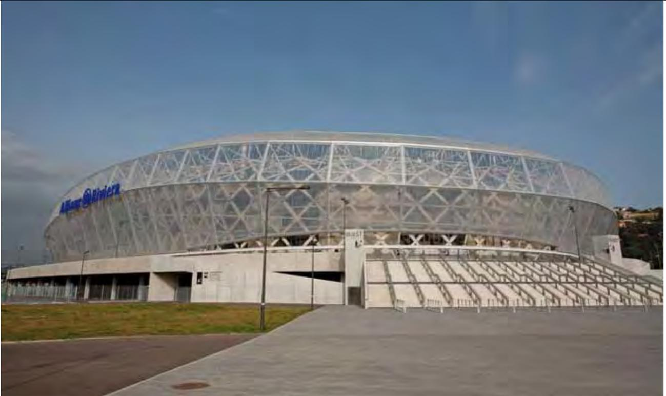
*Inovadora fachada e anel interior construídos com lâminas de ETFE.*
