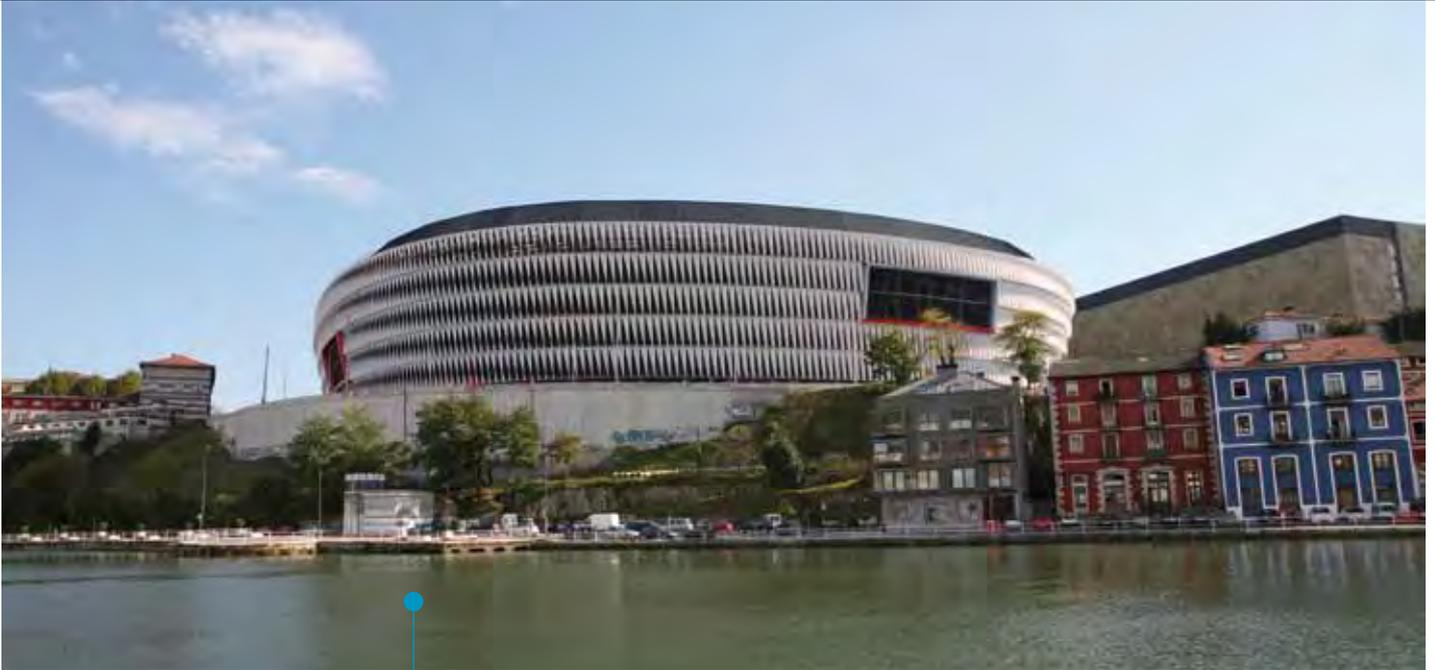
De diferentes perspetivas, observa-se um edifício com dinamismo, que só é possível graças às lâminas de 5,40 m por 1,20 m, com geometria de curvatura dupla.
