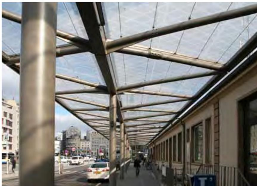
A nova estrutura transmite uma leveza visual de grande beleza, criada a partir de uma geometria em forma de polígono. Este elemento também foi utilizado como base do desenho especial impresso na lâmina de ETFE. A cobertura de peões em forma de telhado invertido de duas águas tem um comprimento de 117 m e uma largura de 8 m.
