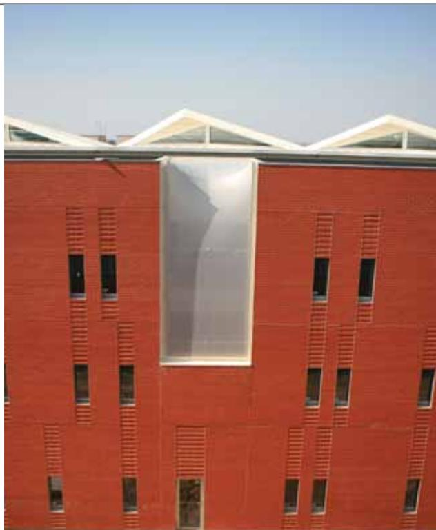
As duas passagens metálicas revestidas de ETFE com um comprimento superior a 18 m e uma altura de 8,5 m estão apoiadas entre as fachadas interiores. A envolvente transparente permite a ventilação natural através das aberturas superiores com forma elíptica.
