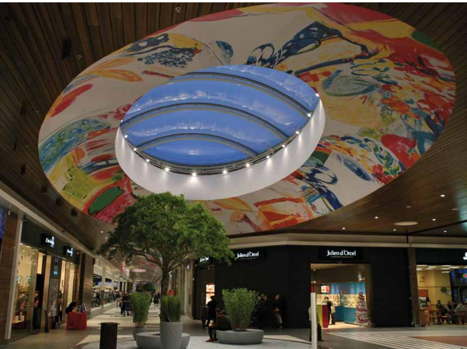
NO CENTRO COMERCIAL LECLERC EM LES PORTES DU VALOIS FORAM CONSTRUÍDAS TRÊS CLARABOIAS E TRÊS COBERTURAS PARA OS ACESSOS DO EDIFÍCIO. NO EXTERIOR, UMA COBERTURA DE MONOCAMADA DE ETFE E NO INTERIOR AS CLARABOIAS DE ALMOFADAS DE ETFE SÃO UMA FONTE DE LUZ QUE PROPORCIONA RIQUEZA À DECORAÇÃO INTERIOR DO CENTRO COMERCIAL.
