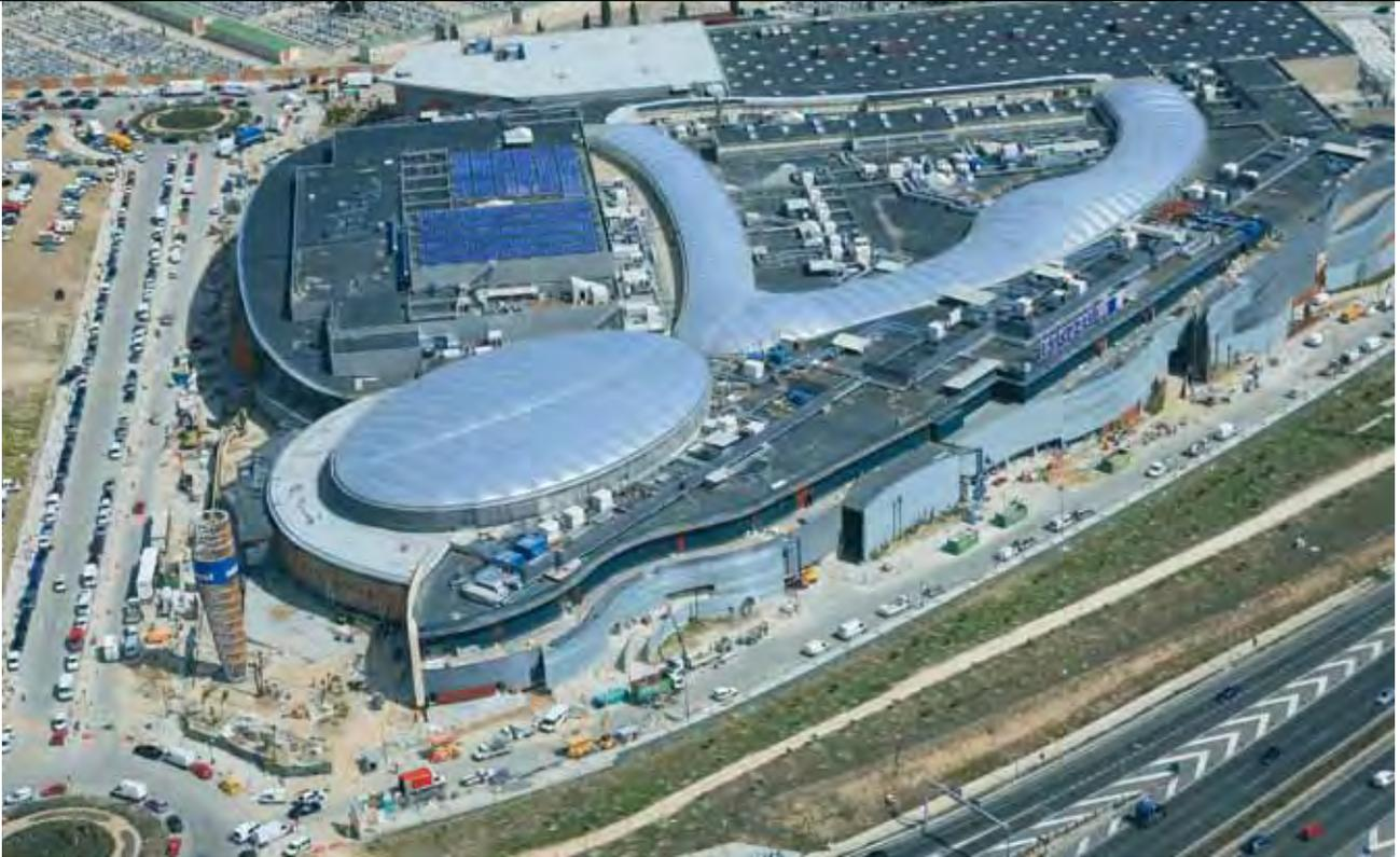
A Praça Caraba destaca-se pela sua forma elíptica e pelas suas dimensões de 80 m de comprimento por 54 m de largura. A outra grande claraboia encontra-se sobre a galeria comercial, onde as almofadas vão de 12 m a 30 m de comprimento, com uma separação entre módulos de aproximadamente 4,4 m.
