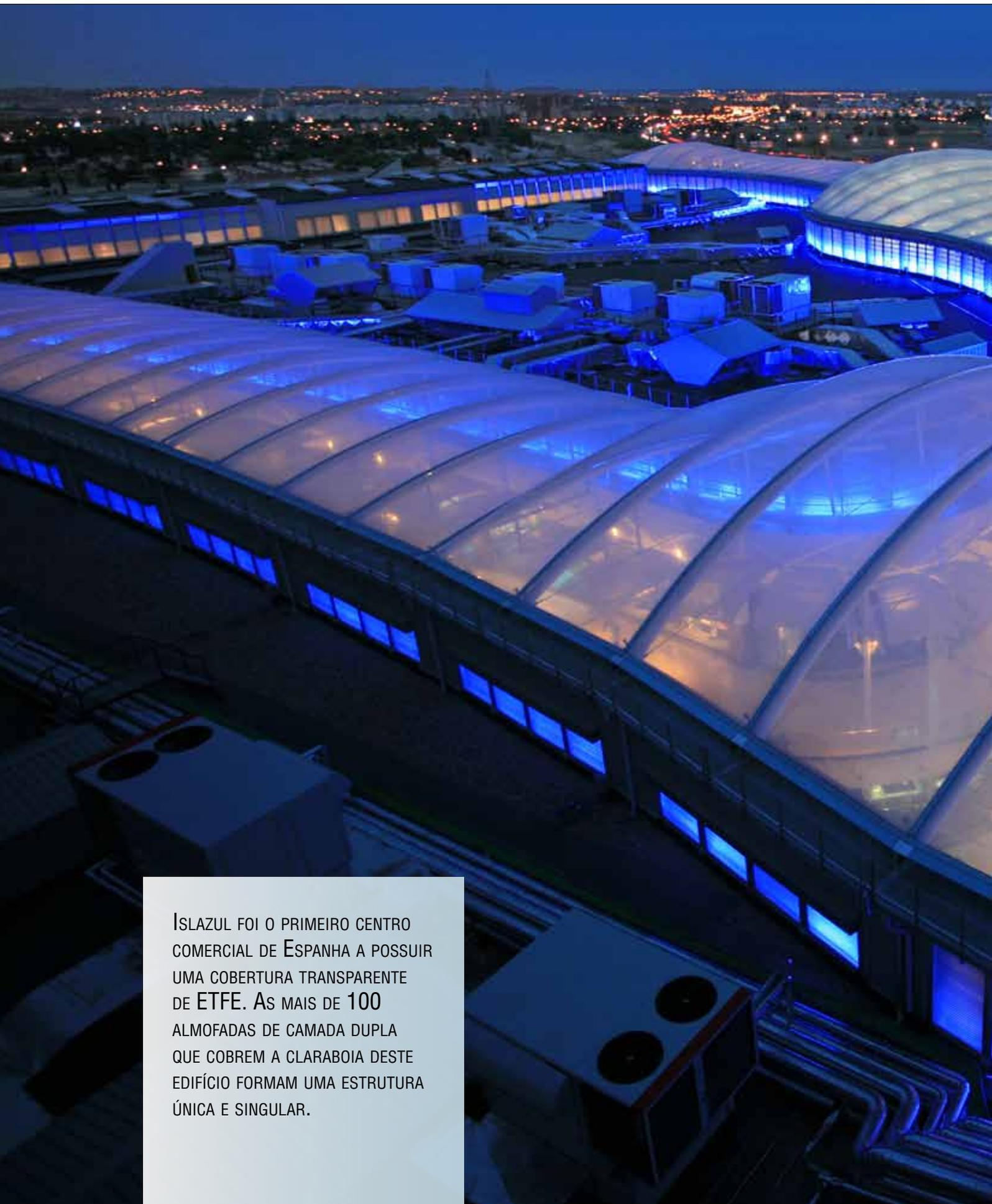
ISLAZUL FOI O PRIMEIRO CENTRO COMERCIAL DE ESPANHA A POSSUIR UMA COBERTURA TRANSPARENTE DE ETFE. AS MAIS DE 100 ALMOFADAS DE CAMADA DUPLA QUE COBREM A CLARABOIA DESTE EDIFÍCIO FORMAM UMA ESTRUTURA ÚNICA E SINGULAR.
