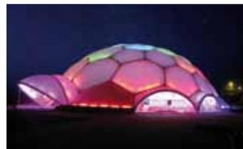
A camada impressa das almofadas reduz a radiação solar do interior da cúpula.
