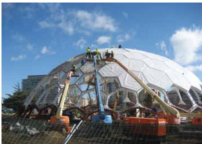
A cúpula é formada por uma estrutura metálica em forma de capacete esférico, de 45 m de diâmetro, composto por polígonos de diferentes medidas. Sobre esta estrutura estão colocadas mais de 84 almofadas de camada tripla. Com duas camadas impressas e uma branca. A transição da cobertura com o pavimento está unida a partir de um jardim vertical que se interrompe com as portas de acesso ao edifício.
