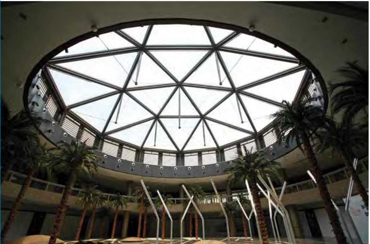
Na grande praça, onde convergem os dois eixos principais do espaço comercial, aparece a cúpula com mais de 25 m de diâmetro. A geometria espetacular da estrutura metálica decompõe a claraboia em 24 almofadas triangulares.
